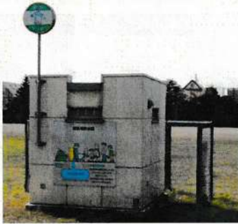
【写真】緊急貯水槽の上屋
